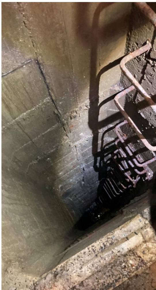
Fotografie 10: Kontrolní šachta u dilatační spáry mezi bloky 9-10 (pohled z horní štoly).
